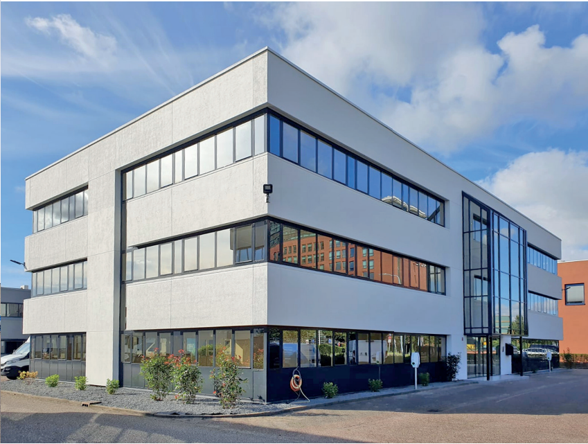
Project in Hoofddorp.
